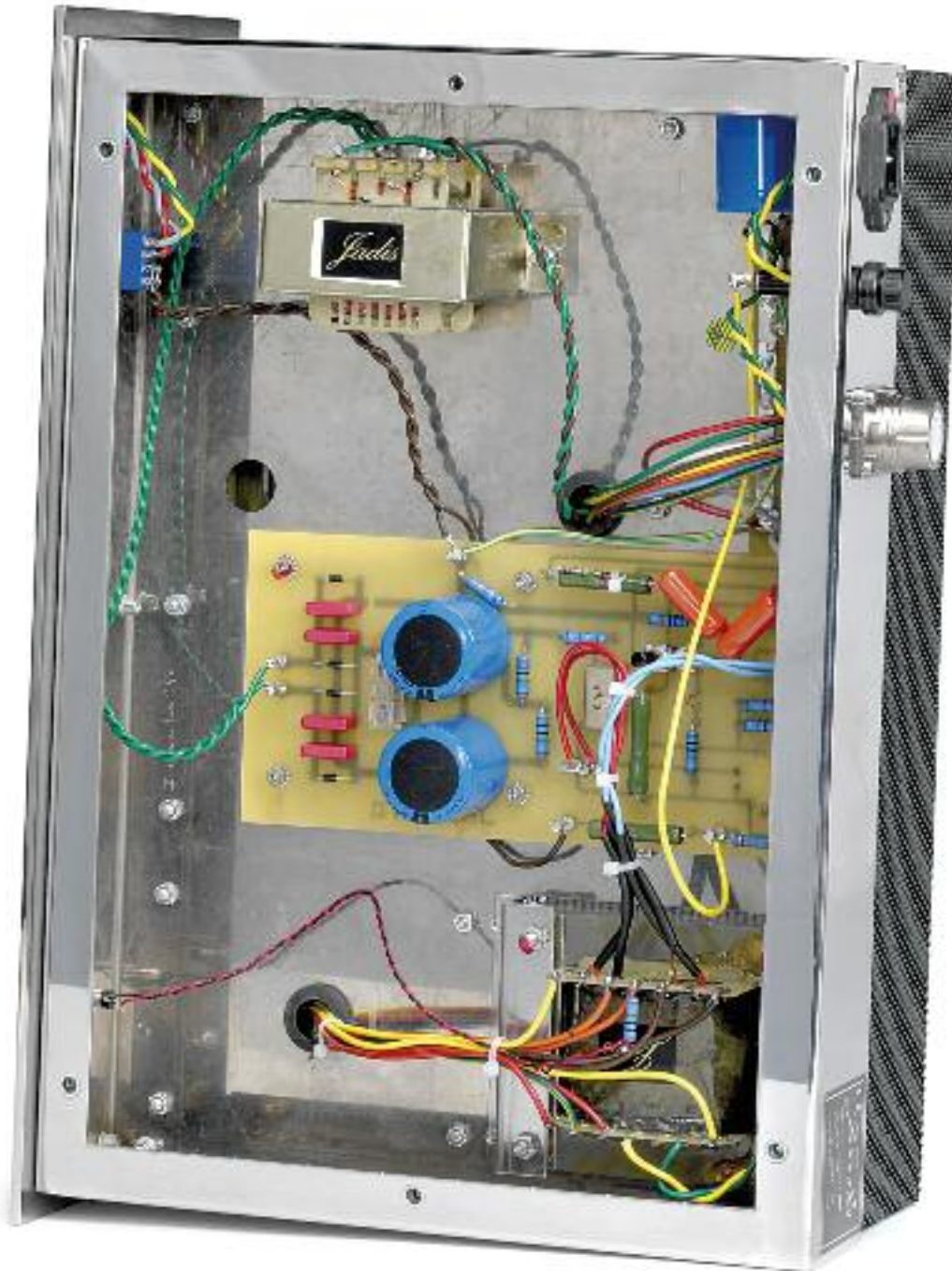
Im Parterre: Hochspannungsübertrager, Röhrenregelung und Netztrafo
